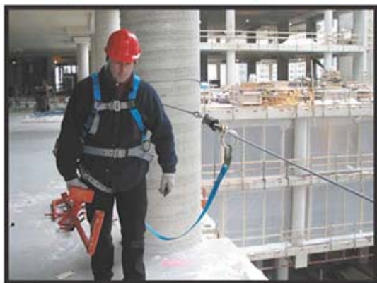
Fig 2 – Utilizzazione con ancoraggio ad elementi strutturali
